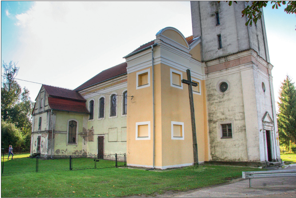
Fot. 1. Północna strona kościoła w Boguchwałach (październik 2020 r.). Z prawej strony widoczna kruchta i wieżyczka schodowa dobudowane w XIX w.; z tyłu, kryta dachem mansardowym, kaplica grobowa Groebenów. Wszystkie zdjęcia pochodzą z prywatnych zbiorów autorki
