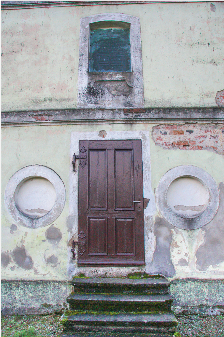
Fot. 4. Wejście do kaplicy Groebenów (dzisiejszej zakrystii). Nad drzwiami miedziana tablica upamiętniająca Marię Luizę
